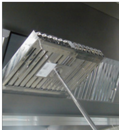
Outil de démontage/remontage du filtre en position.
