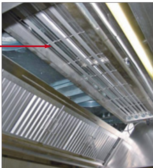
Hotte d'aspiration avec système à lampes UV.
