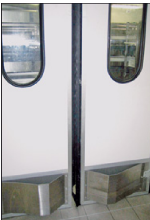
Portes avec profilé « en aile d'avion ».
