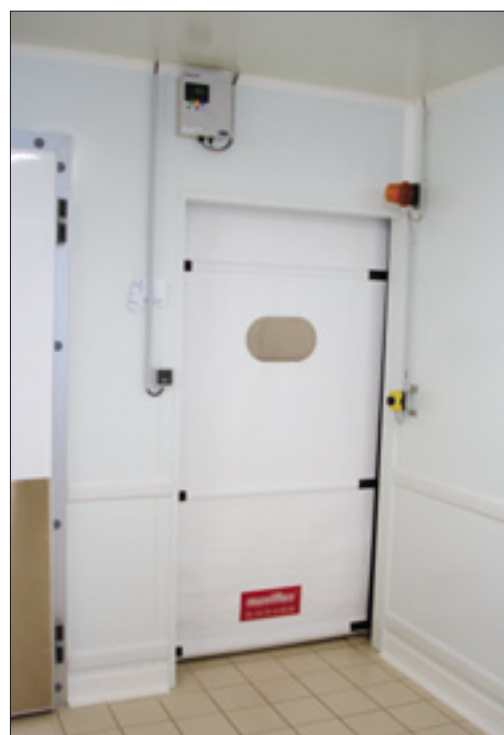
Porte à ouverture automatique avec hublot.
