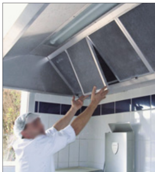
Démontage de plain-pied d'un filtre de hotte.
