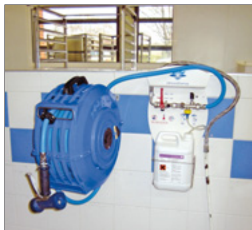
Unité de dilution avec enrouleur articulé.
